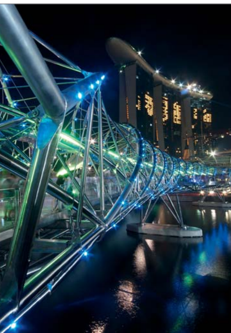
Aplikace duplexních ocelí na mostní konstrukci.
