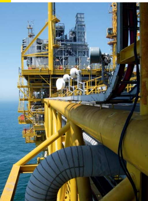
Průmysl offshore: Typický příklad svařování duplexních ocelí.
