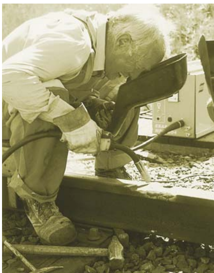
Oprava povrchových zápalů: OK Tubrodur 15.43
