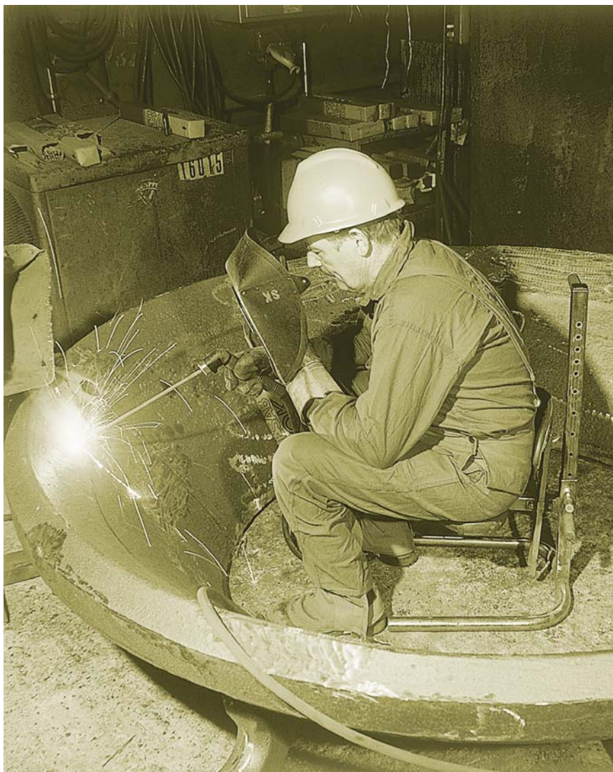
Oprava drtiče z 14% Mn ocele s použitím elektrod OK 86.08
