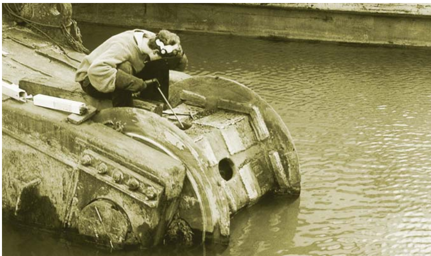
Navařování kladky bagru elektrodou OK 84.84. Obnova tvaru pomocí OK 83.28
