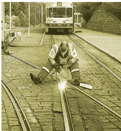
Oprava kolejnic tramvaje: OK 67.52
