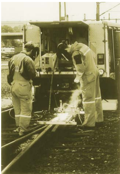
Mechanizované navařování: Railtrac BV/OK Tubrodur 15.43
